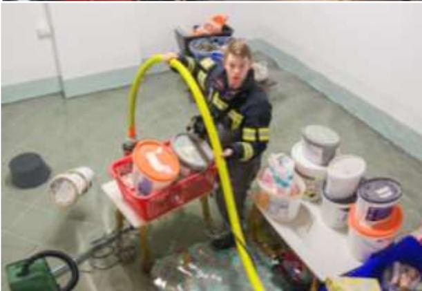
Am 14. Jänner wurde die FF Baden-Stadt zu Auspumparbeiten nach einem Wassergebrechen alarmiert, in einem frisch sanierten Kellerstüberl hatten sich tausende Liter Trinkwasser gesammelt, welche dann von mehreren Unterwasserpumpen sowie Nasssaugern abgepumpt wurden (Foto links).
